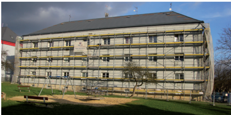
■ Rekonstrukce BD Revírní 4
