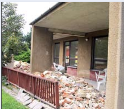
■ Rekonstrukce MŠ Bartovice
