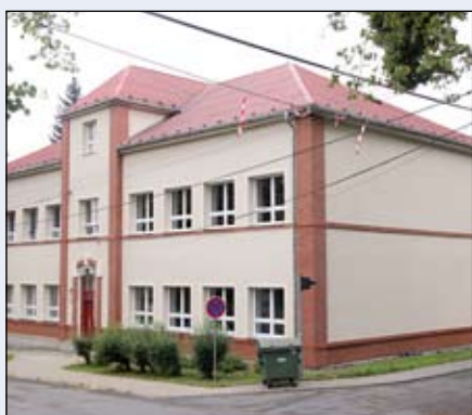
■ Rekonstrukce budov ZŠ Vrchlického
