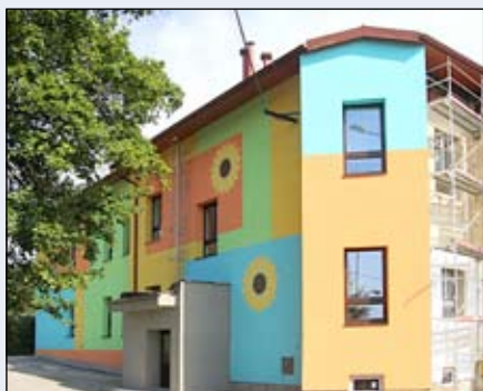
■ Rekonstrukce MŠ Radvanice
