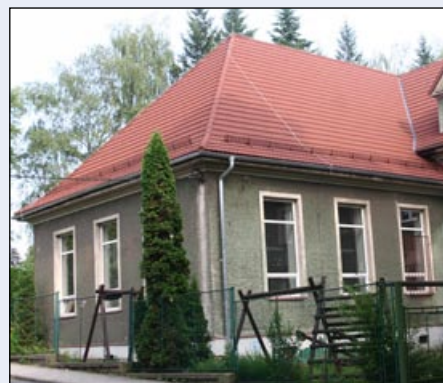
■ Výměna střešní krytiny na ZŠ Vrchlického
