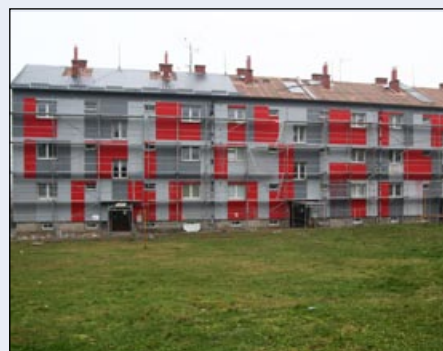
■ Rekonstrukce bytového domu na Třanovské ulici
